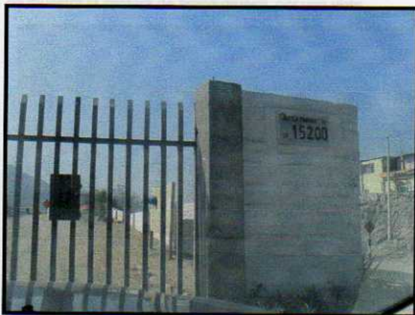
FOTO N°1: Se muestra la entrada a la cantera.
